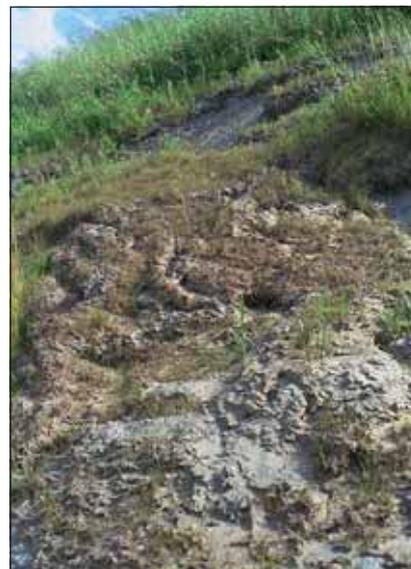
Abb. 28: Hangrutsch nahe Neumarkt i. H. Wie flüssige Lava strömt der nasse Lehm in Richtung Schienen.
