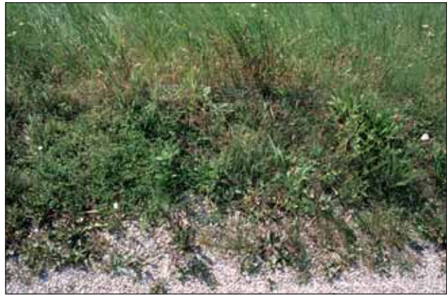
Abb. 5: Besonders am Straßenrand sorgt eingetragener Schotter für lückige Bewuchsverhältnisse.
