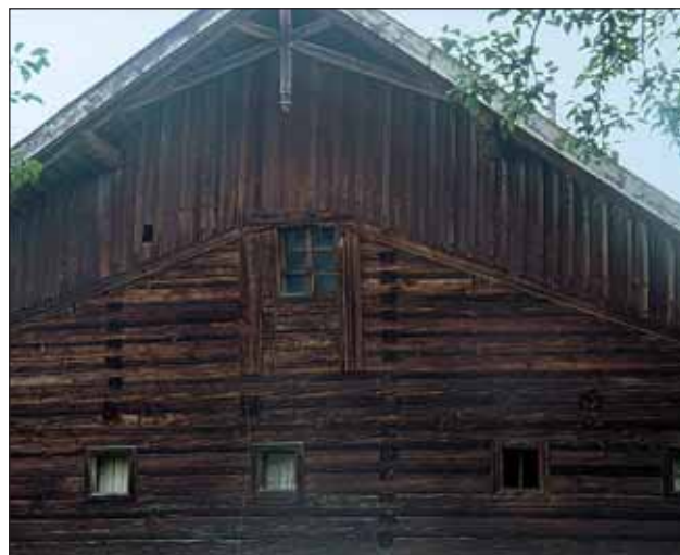
Abb. 8: „Gehobener“ Dachstuhl eines Hauses in Luck bei Münzkirchen. Das Mittelfenster wurde erst bei den Umbauarbeiten eingesetzt.
