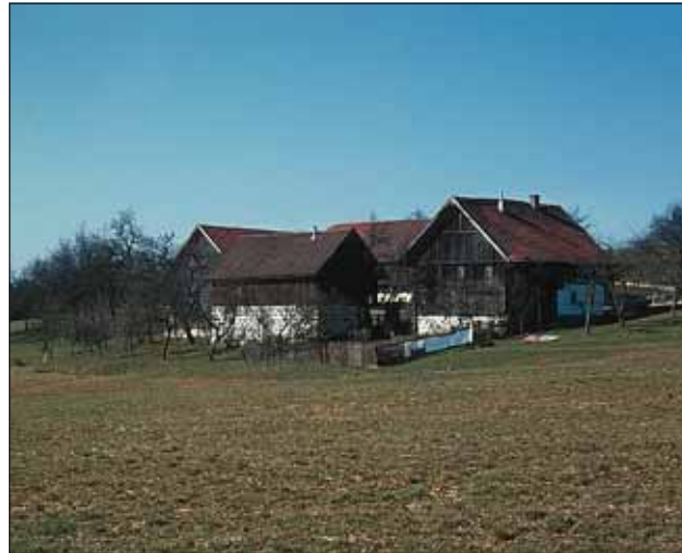
Abb. 7: Kleiner Bauernhof in Entholz östlich Kopfing (1972). Beachte: a: Lage des Hofes, Stallgebäude parallel zum Hang, b: Stallgebäude, Grundfeste von Wohnhaus und Scheune aus Granitblöcken. c: Wohnhaus, Scheune und „Heuboden“ über dem Stallgebäude aus Holz.
