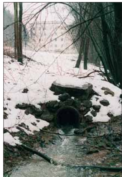
Abb. 6: Das Ende der Verrohrung beim Sonnenhof kann als eigentlicher Bachbeginn gelten.
