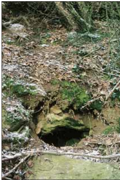
Abb. 20: Die Quelle des Baches 432 ist mit mächtigen Gneisblöcken ausgebaut.
