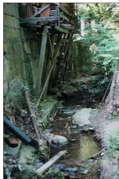
Abb. 10: Hinter den Häusern der Zaubertalstraße 13 und 11 ist der Bach stark bedrängt.
