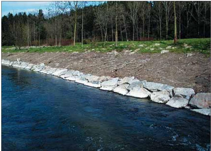
Abb. 3: Durch das Abtragen der Grasnarbe an den Böschungen schwemmen die Frühjahrshochwässer Unmengen Erde ab. Im Bild freigelegte Baumwurzeln.
