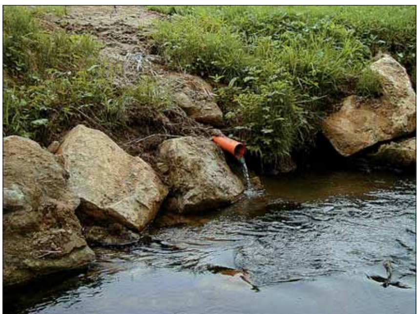
Abb. 7: Erst kürzlich angelegte Drainage inmitten gewaltigen Blockwurfes.
