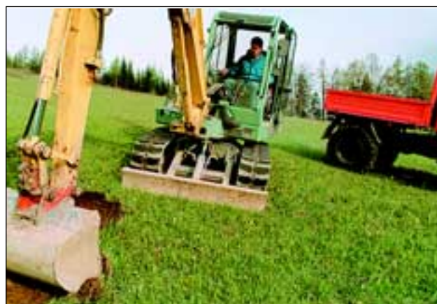
Abb. 16: Vorsichtiges Abtragen des Kalkmagerasens in ca. 60 x 80 cm großen, 10-15 cm dicken Wiesenstücken, mit dem Kleinbagger und Verladen auf den Unimog, welcher an diesem Tag 35 Fahren zur Ersatzfläche brachte.
