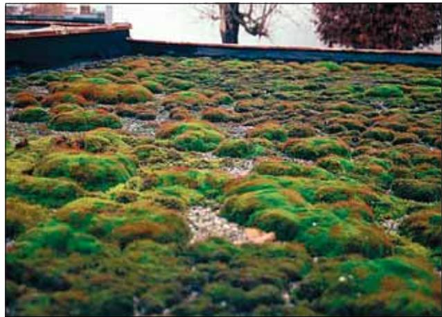
Abb. 5: Flachdach eines Neubaus: Geschotterte Flachdächer werden nach einigen Jahren reichlich von Moosen besiedelt. Sie haben keinen negativen Effekt für die Bauten und sind Heimat einer reichen Welt an Kleintieren (z. B. Bärtierchen).
