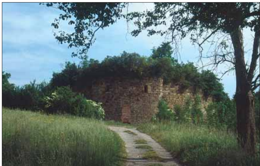
Abb. 7: Im unteren Teil der so genannten Maier-Wiese liegt der frei zugängliche Turm Nr. 20 der Maximilianischen Verteidigungsanlage. Das Mauerwerk ist sehr stark von Gebüsch und Mauerritzenpflanzen bewachsen. Foto: W. Bejvl
