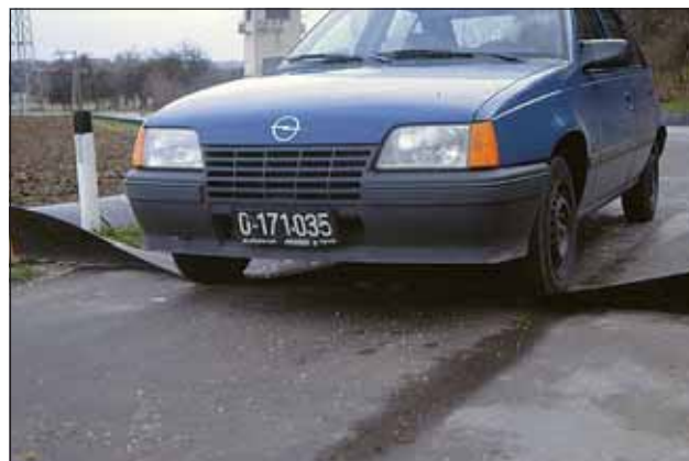
Abb. 22: Überfahrbare Gummilippe bei der Einmündung des Flurweges in den Güterweg Kürnberg.
