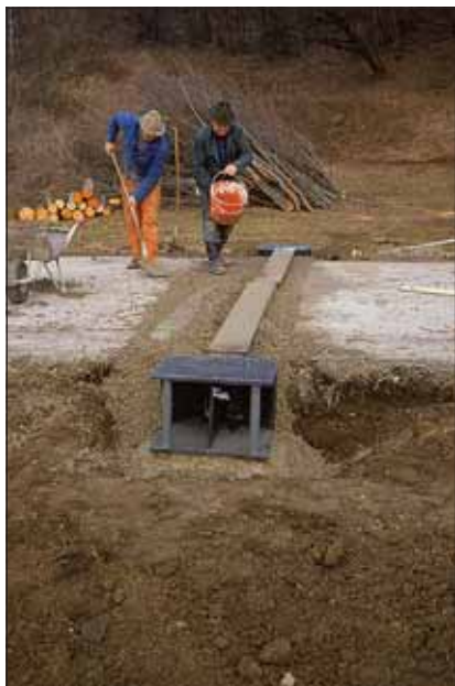
Abb. 19 (links): Einbau der Durchlässe.
