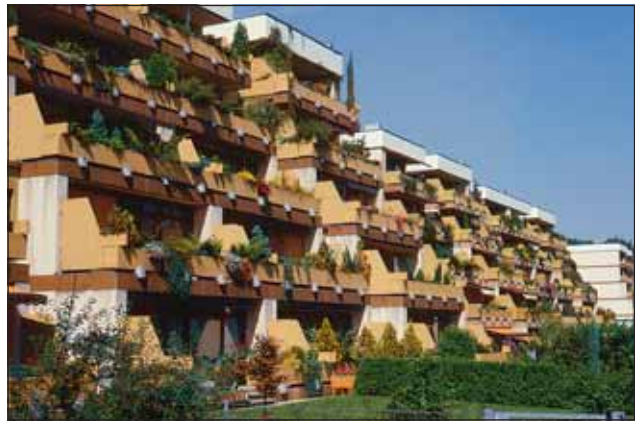
Abb. 7: Mit grünen Balkonen, Terrassen und Vorgärten kann auch bei mehrgeschossigen Wohnbauten Natur gefördert werden. Allerdings ließe sich durch weniger exotisches Ziergrün und mehr heimische Wildpflanzen noch mehr erreichen. Foto: NaSt/Archiv
