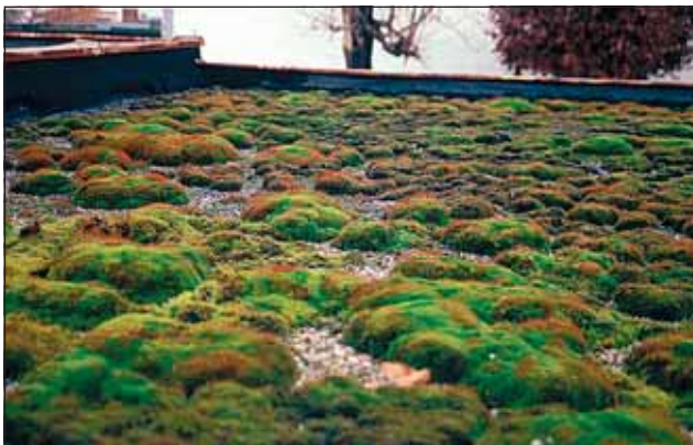
Abb. 5: Flachdach eines Neubaus: Geschotterte Flachdächer werden nach einigen Jahren reichlich von Moosen besiedelt. Sie haben keinen negativen Effekt für die Bauten und sind Heimat einer reichen Welt an Kleintieren (z. B. Bärtierchen). Foto: H. G. Z e c h m e i s t e r
