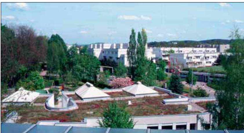
Abb. 9: Bunte Dächer gibt es auch in Wohngebieten: hier im Stadtteil Auwiesen im Linzer Süden. Foto: H. P e r t l w i e s e r / P l a n u n g s a m t
