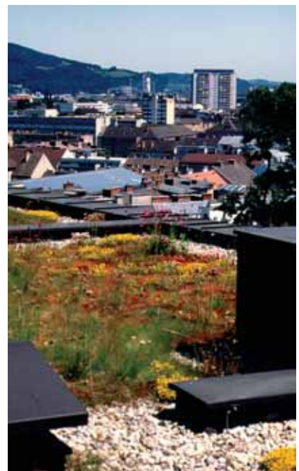
Abb. 1: „Objekt Märzenkeller“. Über den Dächern von Linz - eine Dachbegrünung als Oase. Foto: G. Mann
