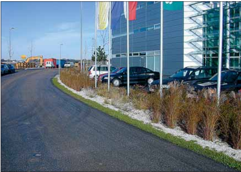
Abb. 6: Versickerungsanlagen müssen nicht hässlich sein. Regenwassermulden vor dem Technologie- und Innovationscenter Steyr mit Chinaschilf und Kiesmulch.
