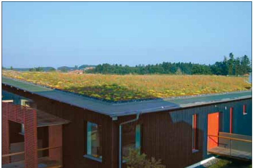
Abb. 5: Trockenstandorte können sich auf Flachdächern mit 10 cm Substratüberdeckung zu einem Feuerwerk der Farben und zu einer Oase des Lebens entwickeln. Als „grüner Pelz“ leisten Gründächer auch einen hervorragenden Beitrag zur Wärmedämmung.
