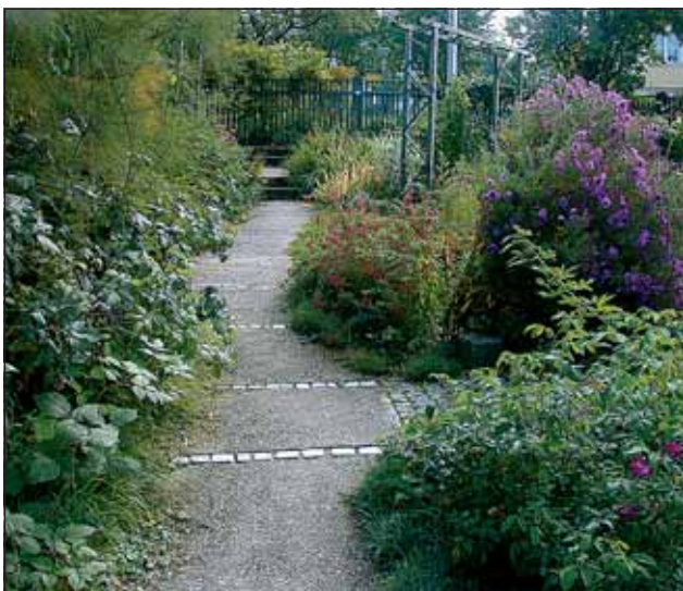
Abb. 1: Betonweg mit Pflasterstreifen in Splitt verlegt, Entwässerung in die angrenzenden Pflanzflächen. Hohe Funktionalität, gepaart mit Versickerung und ansprechender Ästhetik.
