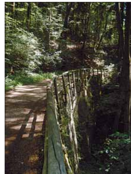
Abb. 12: Als wunderschön verlaufender Waldwanderweg ist die historische Pferdebahntrasse auf der gleichnamigen Promenade noch sehr gut erlebbar. Besonders eindrucksvoll sind die steinernen Viadukte, die über Hangrinnen und Täler führen.
