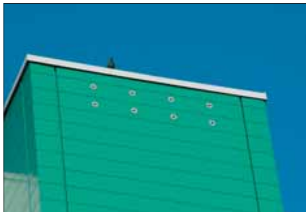
Abb. 3: Das Integrieren von Mauerseglernistkästen in die Wärmedämmung hat sich wegen der günstigen kleinklimatischen Verhältnisse bestens bewährt, da junge Mauersegler leicht zu Überhitzung neigen. Foto: H. Rubenser
