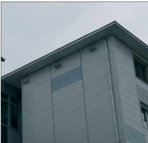
Abb. 9: Eine bewährte Nisthilfe für Mehlschwalben stellt die Montage von Kunstnestern dar - sie werden gerne von den Vögeln angenommen,
