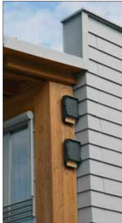
Abb. 13: Fledermäuse gehören zu den bedrohtesten Tierarten in der Stadt. Kleine Maßnahmen wie das Belassen und Schaffen von Spalten und Schlitzen im Dachbereich genügen oft, um damit den Tieren den Zugang in den Dachraum zu ermöglichen. Will man Fledermauskästen an Gebäuden oder Bäumen anbringen, sollte ein Spezialist zurate gezogen werden. Foto: H. Rubenser
