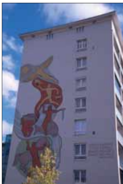
Abb. 4: Hochhäuser mit Flachdach und Gesimse eignen sich besonders dafür, Mauerseglerkästen gruppenweise anzubringen.
