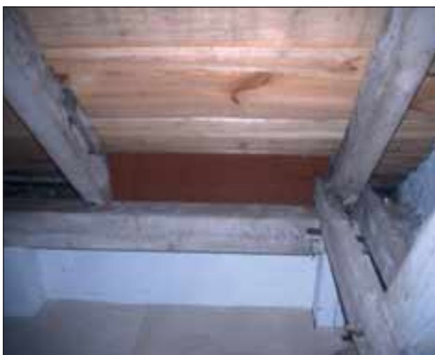
Abb. 5: Verschluss der Brutnischen-Hinterseite, damit den Vögeln der Zugang in den Dachraum verwehrt ist. Foto: H. Rubenser
