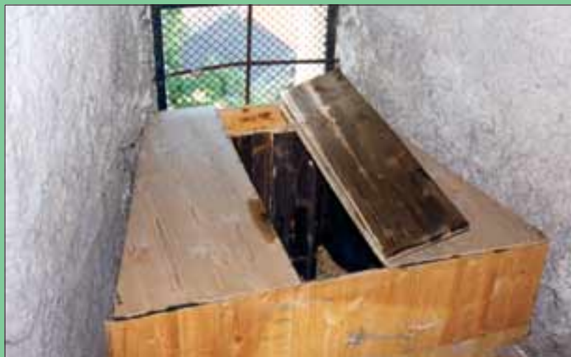
Abb. 8: Nistkasten in einer Fensternische am Kirchturm in Ostermiething; Juli 2003
