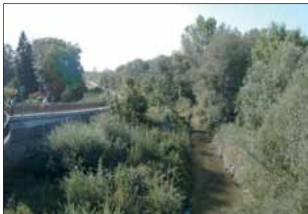
Abb. 7: Feilbach und Strobl-Mühlbach auf der anderen Seite des Damms begleiten den Audamm, der das Ortszentrum von Ebelsberg vor Hochwässern schützen soll. Auf der Dammkrone verläuft ein asphaltierter Geh- und Radweg. Foto: W. Bejvl
