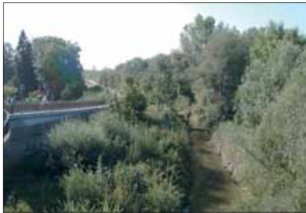
Abb. 7: Feilbach und Strobl-Mühlbach auf der anderen Seite des Damms begleiten den Audamm, der das Ortszentrum von Ebelsberg vor Hochwässern schützen soll. Auf der Dammkrone verläuft ein asphaltierter Geh- und Radweg. Foto: W. Bejvl
