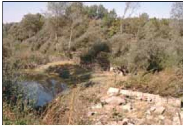
Abb. 10: Ausgedehnte Bühnenfelder kennzeichnen das Überschwemmungsgelände am Traunfluss. Rechts im Vordergrund ist ein häufig überfluteter Querdamm aus Wasserbausteinen zu erkennen. Der Längsdamm ist dicht mit Pionierweiden bewachsen. Dazwischen halten sich Tümpel, die sehr naturnah sind. Foto: W. Bejvl
