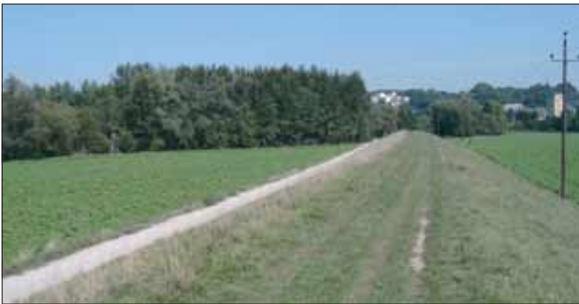
Abb. 16: Der geradlinig verlaufende Hochwasserschutzdamm trennt das Augebiet vom umliegenden Kulturland. Er ist zwar landschaftlich keine Augenweide, aber zum Schutz vor Hochwasser trotzdem von Bedeutung und auch ökologisch durchaus nicht zu verachten: An der südexponierten Böschung befindet sich einer der wenigen Magerwiesenstandorte des Linzer Südens. Im Hintergrund ist bereits das Schloss Ebelsberg zu erkennen. Foto: W. Bejvl
