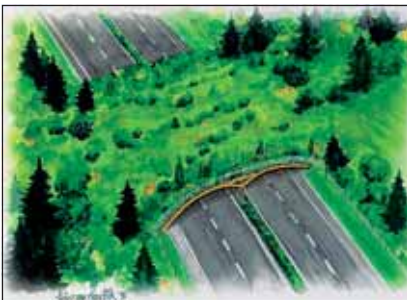
Abb. 7: Grünbrücken sind als Lebensraumvernetzung für Wildtiere besonders wichtig bei stark befahrenen Straßen. Die Durchlässigkeit von Bauten sollte generell mehr Berücksichtigung finden.
