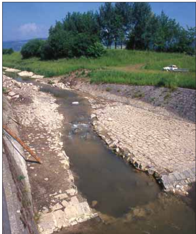
Abb. 11: Am Ende der Renaturierungsstrecke wurde eine gepflasterte Sohlschwelle, die ein unüberwindliches Hindernis für Bachtiere darstellte, aufgerissen. Das Wasser fließt nun barrierefrei in das Sandfangbecken, das unterhalb der Schwelle anschließt. Foto: F. Schwarz
