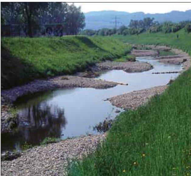
Abb. 4: Das Sammelgerinne nach Abschluss der Renaturierungsarbeiten im Jahr 1994. Mit Schottervorschüttungen wurde eine abwechslungsreiche Ufergestaltung vorgenommen, Holzelemente bringen Belebung in den Bachlauf. Die Bepflanzung fehlt zum Zeitpunkt der Aufnahme noch.
