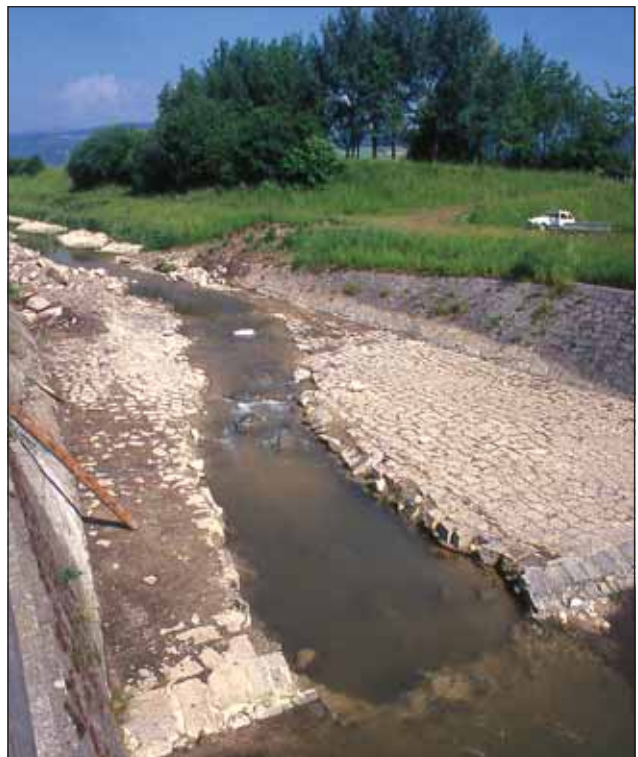
Abb. 11: Am Ende der Renaturierungsstrecke wurde eine gepflasterte Sohlschwelle, die ein unüberwindliches Hindernis für Bachtier darstellte, aufgerissen. Das Wasser fließt nun barrierefrei in das Sandfangbecken, das unterhalb der Schwelle anschließt. Foto: F. Schwarz
