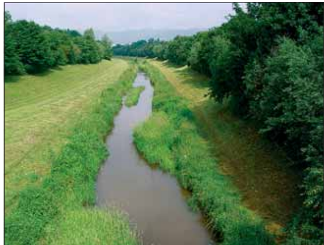
Abb. 3: Das Urfahrer Sammelgerinne wurde im Zuge der Errichtung des Donaukraftwerkes Abwinden-Asten errichtet und dient dazu, die aus Urfahr in das Stadtgebiet zufließenden Bäche abzuleiten. Die Formgebung ist ein Spiegel der Zeit: in den 60er und 70er Jahren waren trapezförmige Querschnitte und einheitliche Ufer- und Sohlgestaltungen üblich.
