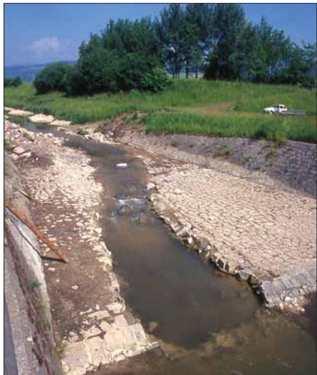
Abb. 11: Am Ende der Renaturierungsstrecke wurde eine gepflasterte Sohlschwelle, die ein unüberwindliches Hindernis für Bachtiere darstellte, aufgerissen. Das Wasser fließt nun barrierefrei in das Sandfangbecken, das unterhalb der Schwelle anschließt. Foto: F. Schwarz
