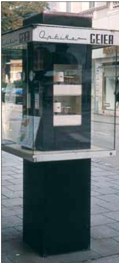
Abb. 4 (links): Die Wetterstation bei der Einmündung der Promenade ist mit Gabbro, einem tief-schwarzen, feinkörnigen Magmatit, verkleidet.
