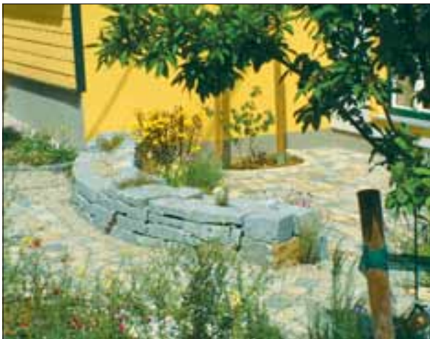
Abb. 11: Trockenmauern sind nicht nur zur Terrassierung und Hangstützung geeignet; diese Granitmauer dient als trennendes Element zwischen Weg und Sitzplatz.
