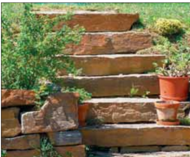
Abb. 13: Diese Blockstufen aus Hartgneis unterbrechen den Verlauf einer Trockenmauer und bringen die Bewohner auf eine höhere Gartenebene.
