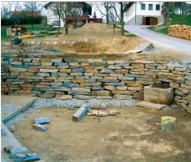
Abb. 7: Diese Trockenmauer aus Hartgneis wird nach der Fertigstellung den Rahmen für eine Terrasse beim Haus bilden und ist ...
