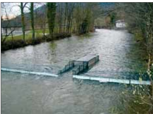
Abb. 5: Das dynamische Fischwehr mit integriertem Reusenkasten, in dem im Frühjahr 2004 in die Seeache einwandernde Perlfische gefangen wurden.
