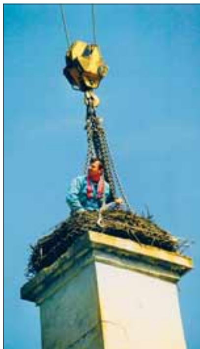
Abb. 19: Mutige Bauarbeiter bei der Horstrenovierung.
