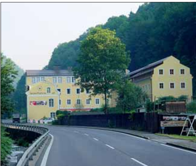
Abb. 14: Die ehemalige Lederfabrik, die 1843 gegründet wurde und bis in die 60er-Jahre in Betrieb war, steht als markanter Bau direkt an der Leonfeldner Straße. Foto: H. Rubenser
