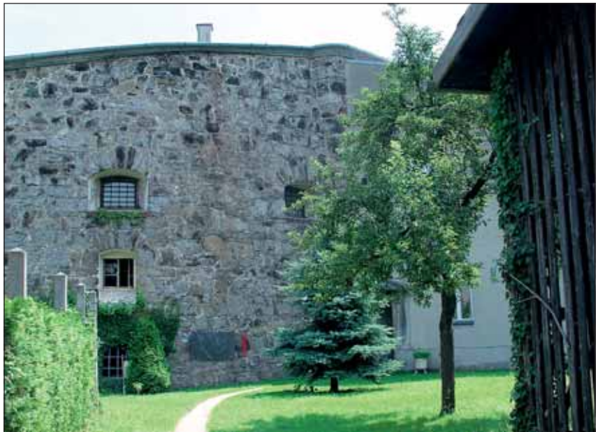
Abb. 14: Der „25er-Turm“ mitten im Hafenviertel gehört zu den am besten erhaltenen Türmen der Maximilianischen Befestigungsanlage, die in den 20er- und 30er-Jahren des 19. Jahrhunderts rund um Linz errichtet wurden.
