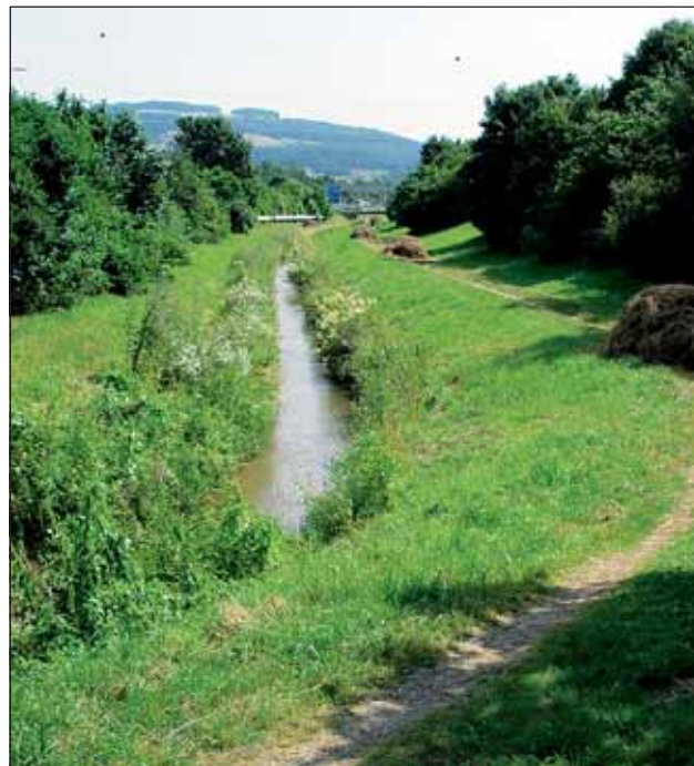
Abb. 5: Das Sammelgerinne nimmt das Wasser aller Urfahrer Bäche auf und leitet es donauparallel unterhalb des Kraftwerkes Abwinden-Asten der Donau zu. Im oberen Abschnitt sieht es noch ziemlich kanalartig aus, weiter unten beim Pleschinger See wurde es vor einigen Jahren renaturiert.
