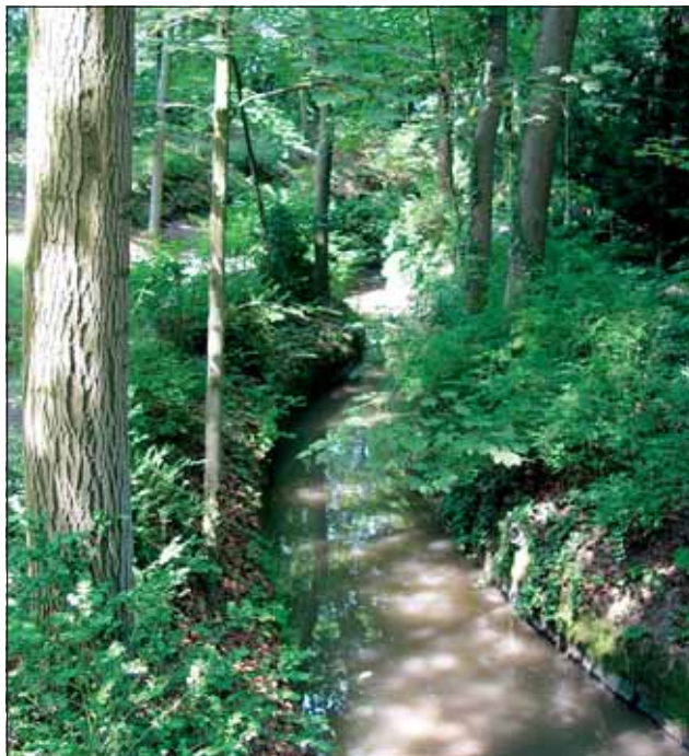
Abb. 4: Der Dießenleitenbach durchfließt den Urnenhain. Sein Verlauf ist zwar noch natürlich, das Bachbett jedoch in Beton gefasst. Der Grund dafür: Grundwasserschutz! Unsauberes Bachwasser darf nicht in den Grundwasserkörper dringen und das Trinkwasser verschmutzen.
