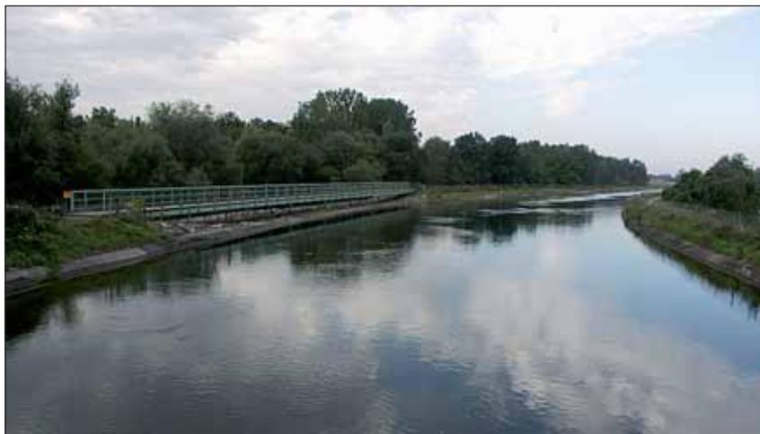
Abb. 3: Mit „Bach“ hat der sogenannte Jaukerbach nichts mehr gemein. Als rein technisches Bauwerk dient er lediglich als Zuleitungskanal von Traunwasser zum Kraftwerk Kleinmünchen.
