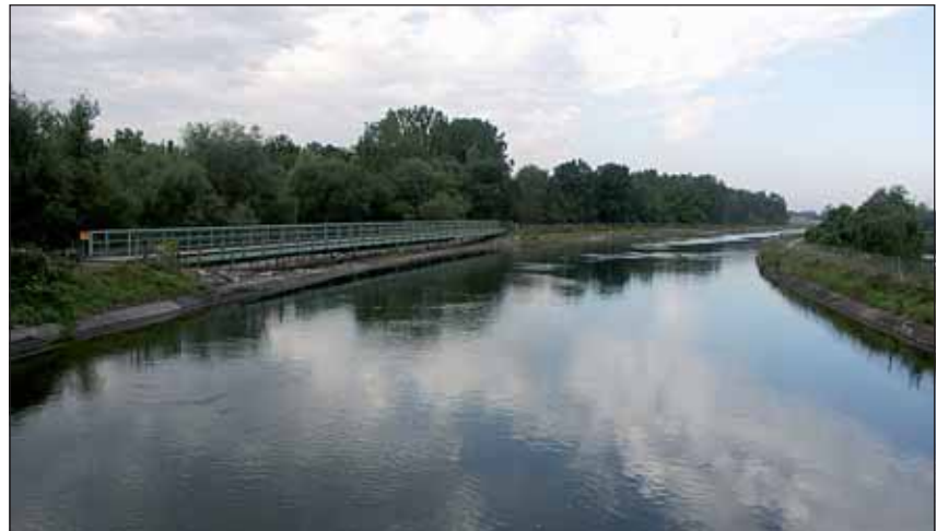
Abb. 3: Mit „Bach“ hat der sogenannte Jaukerbach nichts mehr gemein. Als rein technisches Bauwerk dient er lediglich als Zuleitungskanal von Traunwasser zum Kraftwerk Kleinmünchen. Foto: W. B e j v l
