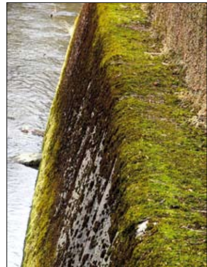
Abb. 3: Die Mauerkrone fängt alle Niederschläge, deshalb der lückenlose Moosbewuchs; auch im Bereich unterhalb der Kante.
