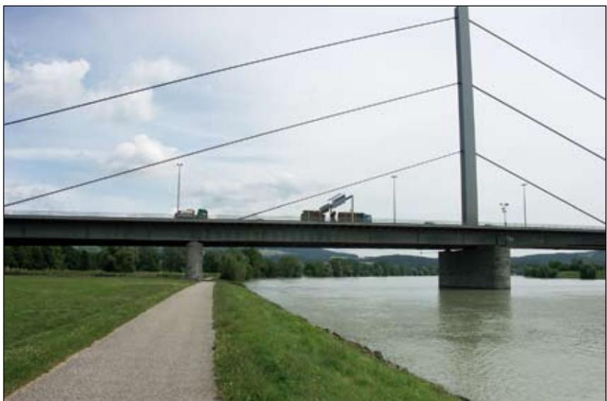
Abb. 18: Die Autobahn- oder auch Voest-Brücke ist mit ihrem großen Mittelpfeiler, an den die Brücke mit Stahlseilen gehängt ist, auch ein architektonisches Wahrzeichen des Linzer Donauroumes.
