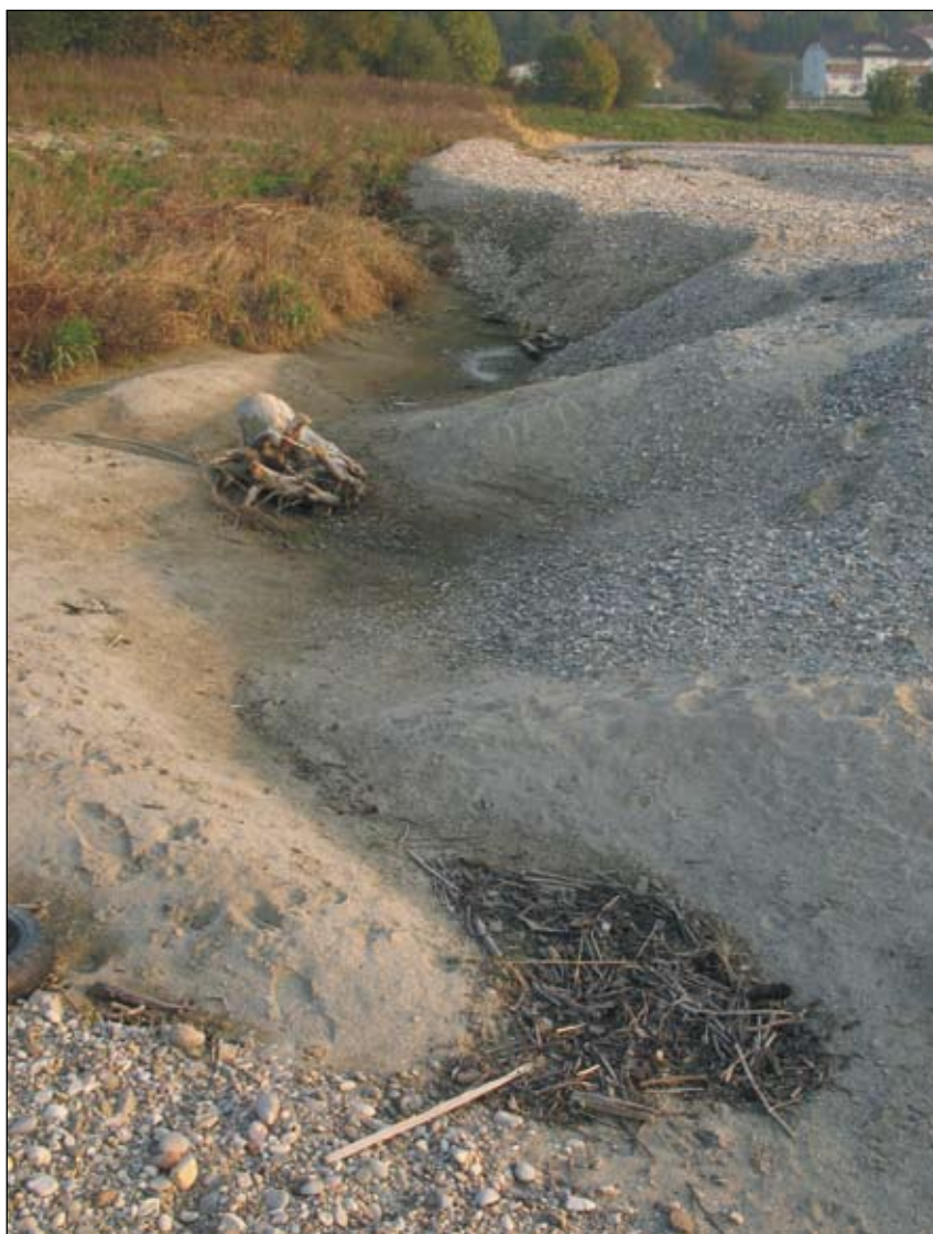
Abb. 24: In großen Teilbereichen der großflächigen Geländeabsenkungen waren bereits im Oktober 2007 zehn Monate nach der Fertigstellung entsprechend den Strömungsverhältnissen bei den Hochwasserabflüssen die Ausbildung von deutlichen Strömungsrinnen und sehr unterschiedliche Ablagerungen von Feinsand bis Schotter erkennbar.
