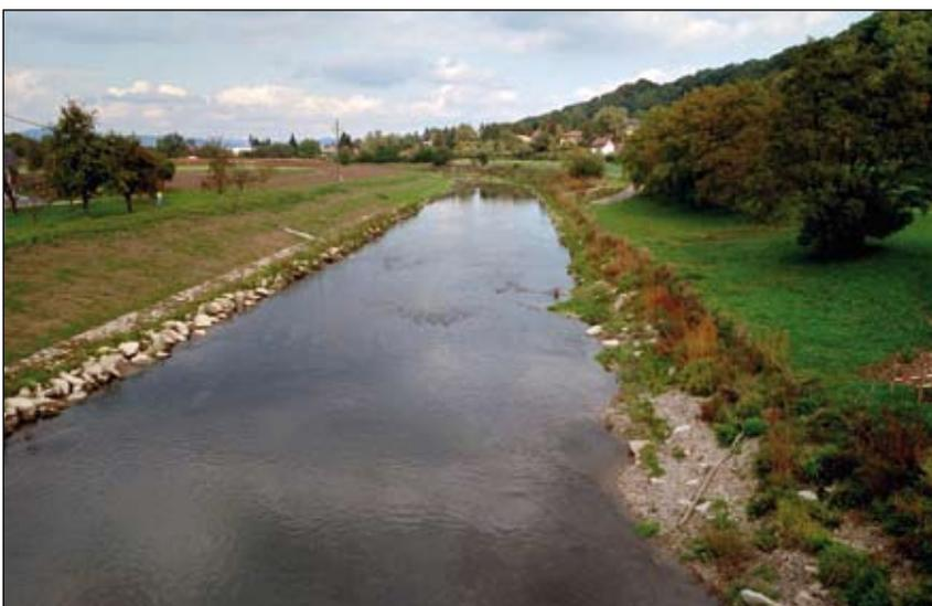
Abb. 2: Die Krems am Ende des monotonen und strukturarmen Regulierungsabschnitts aus den 1950er-Jahren, knapp oberhalb des Projektbereiches, Blick flussabwärts - die kleinen rechtsufrigen Schotterbänke wurden, so wie bereits am linken Ufer, kurz darauf ebenfalls geräumt.
