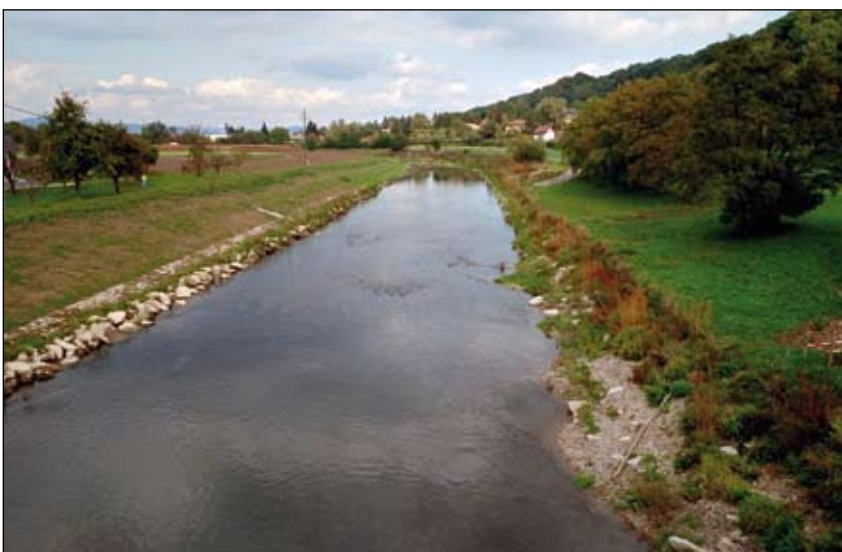
Abb. 2: Die Krems am Ende des monotonen und strukturarmen Regulierungsabschnitts aus den 1950er-Jahren, knapp oberhalb des Projektbereiches, Blick flussabwärts - die kleinen rechtsufrigen Schotterbänke wurden, so wie bereits am linken Ufer, kurz darauf ebenfalls geräumt.
