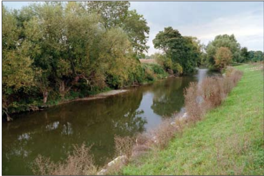
Abb. 6: Krems vor den Baumaßnahmen, Blick flussabwärts, etwas unterhalb Beginn des Projektabschnitts (nahe Ende des Linksbogens). Die bestehenden Ufergehölze konnten fast zur Gänze auch im Projekt erhalten werden.
