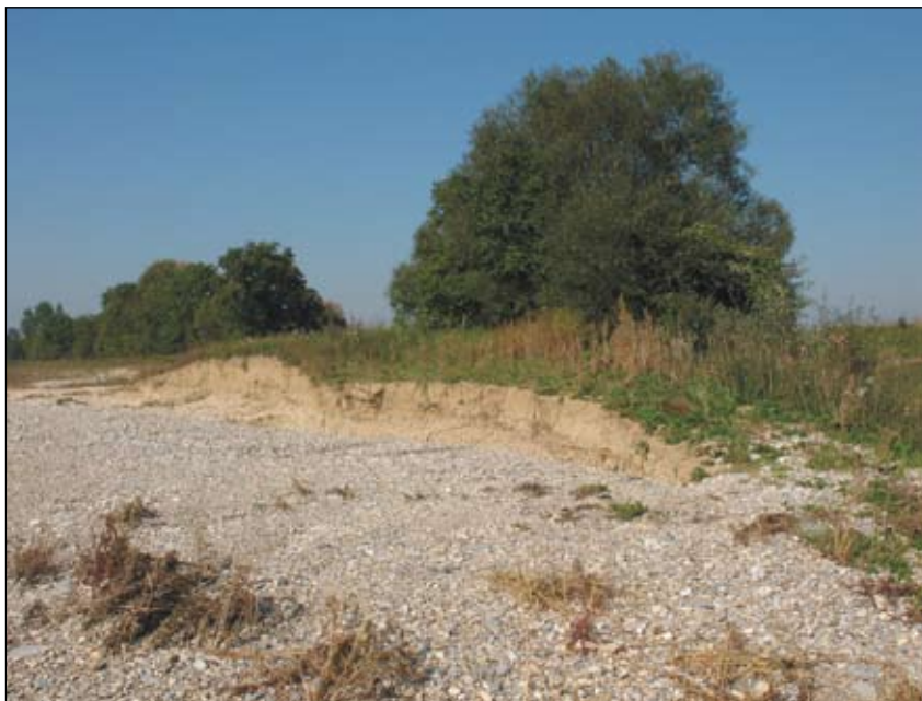
Abb. 23: An einigen, bei Hochwasserabflüssen stärker angeströmten Stellen der verbleibenden Inseln und Kremsufer haben sich - wie in der Projektplanung durchaus vorgesehen und erwartet - nach der Fertigstellung sehr rasch lokale Steilufer mit Uferanbrüchen ausgebildet. (Foto September 2007).
