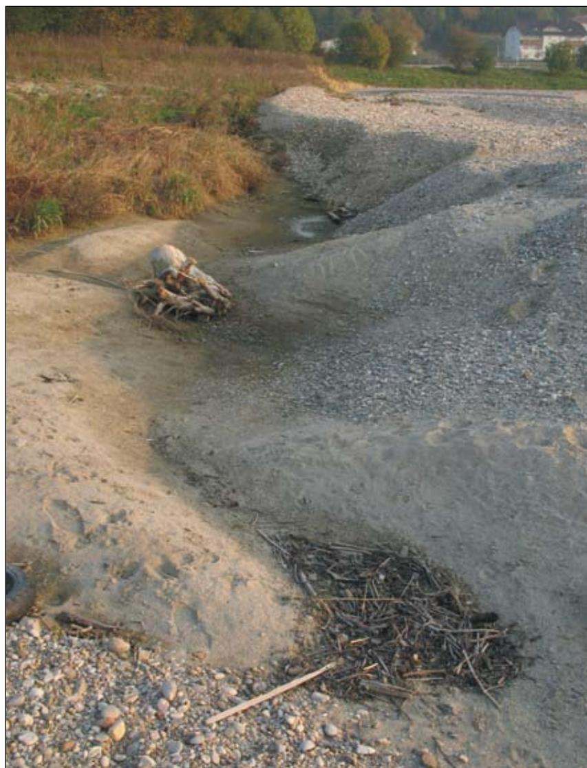
Abb. 24: In großen Teilbereichen der großflächigen Geländeabsenkungen waren bereits im Oktober 2007 zehn Monate nach der Fertigstellung entsprechend den Strömungsverhältnissen bei den Hochwasserabflüssen die Ausbildung von deutlichen Strömungsrinnen und sehr unterschiedliche Ablagerungen von Feinsand bis Schotter erkennbar.
