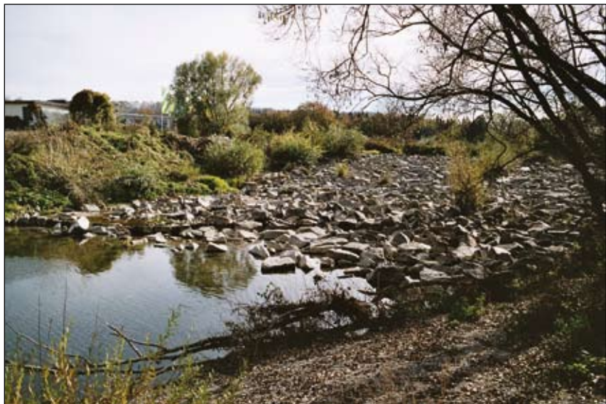
Abb. 7: Die Blockstein-Wehrrampe, Blick flussaufwärts, nahe dem Ende des Projektabschnitts. Die hier erforderliche Umgestaltung der Wehrrampe (einschließlich Pflicht-Mindestwasserdotierung) zur Verminderung der Unterbrechung des Gewässerkontinuums und Verbesserung der Durchgängigkeit konnte im Rahmen des Projekts nicht bearbeitet werden und bleibt eine zukünftige Aufgabe.
