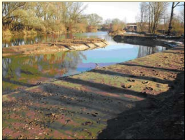
Abb. 35: Zustand nach 1. kleinem Hochwasser mit Feinsedimentablagerungen und ersten kleinen Ufererosionen (27. 11. 2008).
