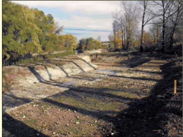
Abb. 33: Bauzustand mit Nebenarm bei Beginn der Flutung, die Insel und ein breiter Uferstreifen wurden abgesenkt (5. 11. 2008).
