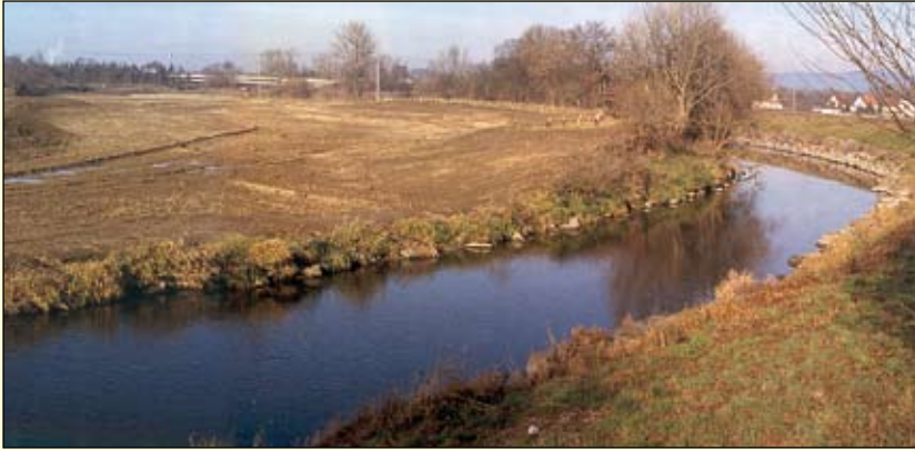
Abb. 5: Zustand am Ende der Erdbauarbeiten vor Flutung des Seitengerinnes. Die Steine der alten Ufersicherung am linken Kremsufer wurden später noch entfernt. Die Einbauten im Kremsbett sind noch nicht erfolgt (14. 12. 2006).
