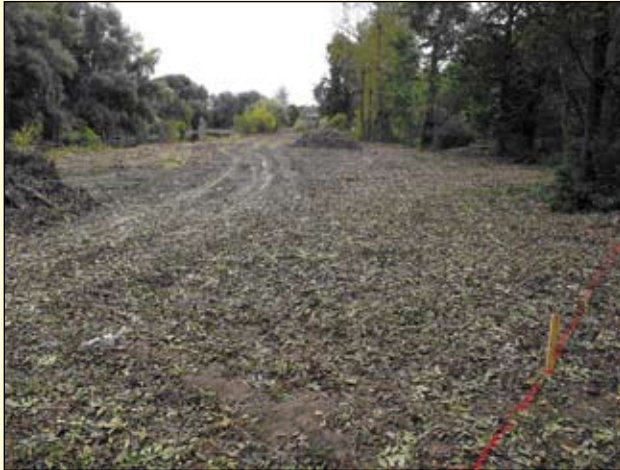
Abb. 32: Blick flussabwärts, Zustand bei Baubeginn (2. 10. 2008).
