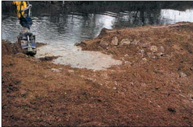
Abb. 2: Um eine kontrollierte Wasserentnahme aus der Krems vorzunehmen, wurde als Einlaufbauwerk am unteren Ende des linksufrigen Seitengerinnes eine (vorübergehende) Blocksteinrampe mit kleinem Überströmbereich hergestellt ...
