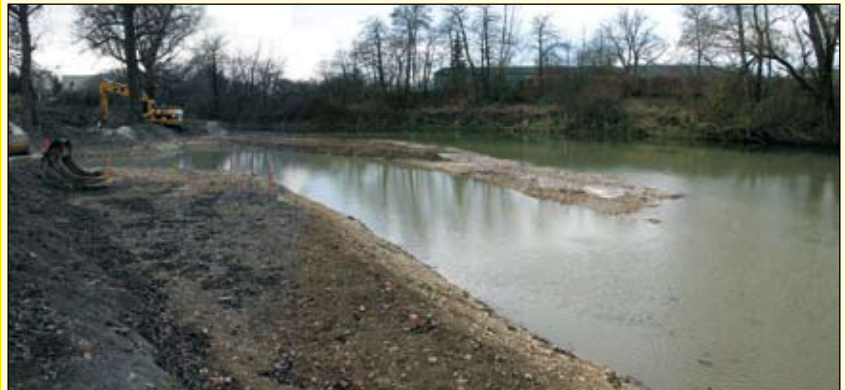
Abb. 30: Nebenarm mit Belassung einer tiefliegenden Landzunge zur Krems hin, im Vordergrund am Ufer breite Geländeabsenkung. Bauzustand 20. 11. 2008
