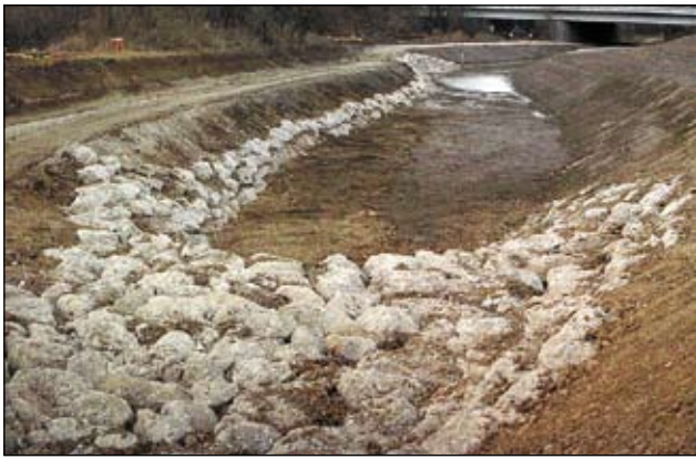
Abb. 8: Abgesehen von den Steinbuhnen in der Krems mussten nur am rechten Seitengerinne zur Sicherung der beiden Einströmbereiche und des Weges Konglomeratsteine verlegt werden. Bauzustand vor Gerinneflutung (3. 2. 2007)
