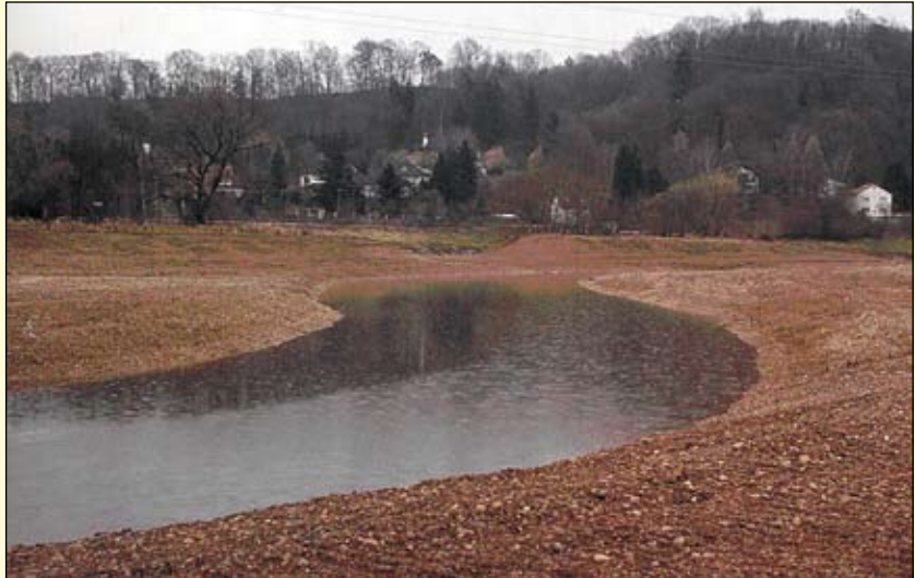
Abb. 22: Zustand nach Fertigstellung und Flutung (4. 1. 2007)
