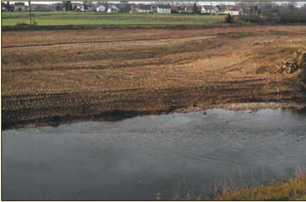
Abb. 10: Nach Fertigstellung, noch vor Flutung des linksufrigen Seitengerinnes (5. 12. 2006)
