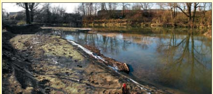
Abb. 31: Bereits das erste kleine Hochwasser hat wie erwartet die Landzunge zur Krems hin etwas erodiert und im Vordergrund auf der Geländeabsenkung sowie am Ufer erste Sedimente abgelagert. Die natürliche Entwicklung hat begonnen (27. 11. 2008).
