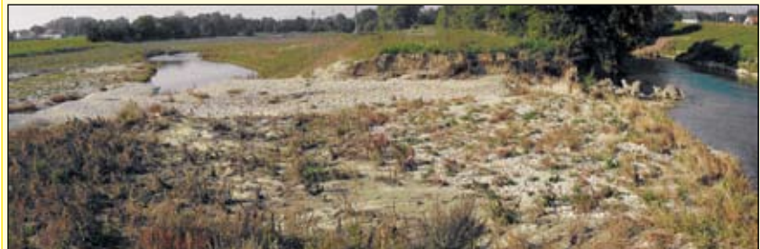
Abb. 18: Uferabbruch erweitert, rechts die Krems; das Seitengerinne ist im obersten Teilstück bereits weitgehend verfüllt (24. 9. 2007)
