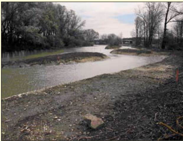
Abb. 34: Nach Fertigstellung: Insel wurde bereits bepflanzt, Weidensteckhölzer an Uferböschungen fehlen noch (20. 11. 2008).
