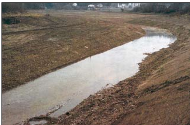
Abb. 4: Die (kontrollierte) Auffüllung dieses knapp 500 Meter langen und großflächigen Seitengerinnes dauerte etwa einen Monat lang. Blick vom Einströmbereich gerinneaufwärts.
