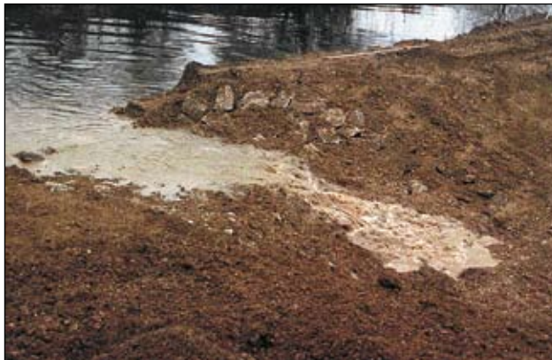
Abb. 3: und am 19. 12. 2006 durch die Öffnung mit der Flutung dieses Seitengerinnes begonnen.
