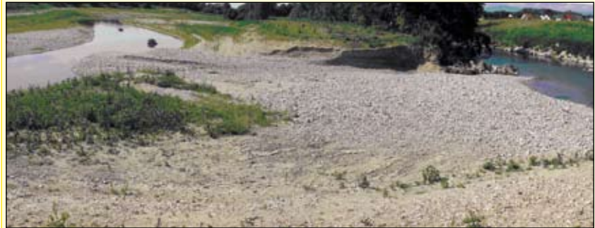
Abb. 17: Neuer Uferabbruch am oberen Ende der 2. Insel, rechts die Krems, links das Seitengerinne (31. 5. 2007)
