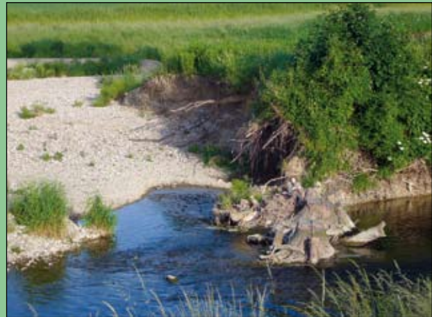
Abb. 10: Die Wurzelstockbuhne im Mai 2008 bei Niedrigwasser. Vor der Wurzelstockbuhne hat sich bereits eine größere Bucht entwickelt. Die Verbindung zwischen dem Hauptarm und dem Sekundärarm besteht nur bei Hochwässern. Der Uferbereich der Insel weist größere Uferanbrüche auf. Es ist zu erwarten, dass sich die Verbindung zwischen den beiden Kreamsarmen im Laufe der nächsten Jahre weiterentwickeln wird und schließlich auch bei Niedrigwassersituationen eine dotierte Tiefenrinne besteht.
