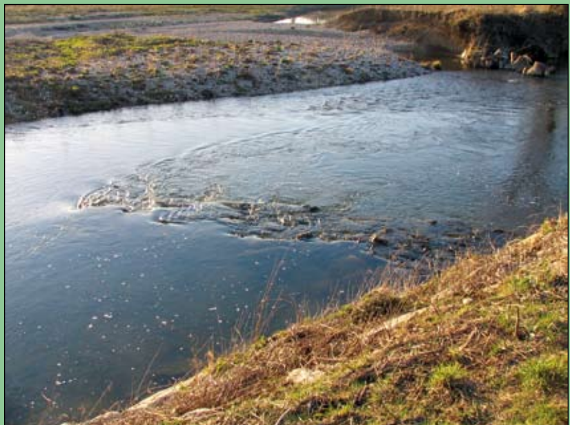
Abb. 7: Strömunglenkung an einer der Steinbuhnen: Ab der Mittelwasserführung der Krems werden die Steinbuhnen überströmt. Gut zu erkennen ist die seitliche Ablenkung der Strömung nach links. Durch die raue Ausgestaltung der Buhnenkrone kommt es zu einer sehr heterogenen Strömungsbildung im Überströmbereich. Bei Wasserständen unter Mittelwasser kommt es im Strömungsschatten der Buhne zur Sedimentation. Bei Hochwasser wird die Buhne überströmt und die dadurch auftretenden Strömungen führen zur neuerlichen Erosion der Ablagerungen aus dem Strömungsschatten. Bei normalen Abflussbedingungen wird dieser Kolk wieder sukzessive mit Substrat aufgefüllt.
