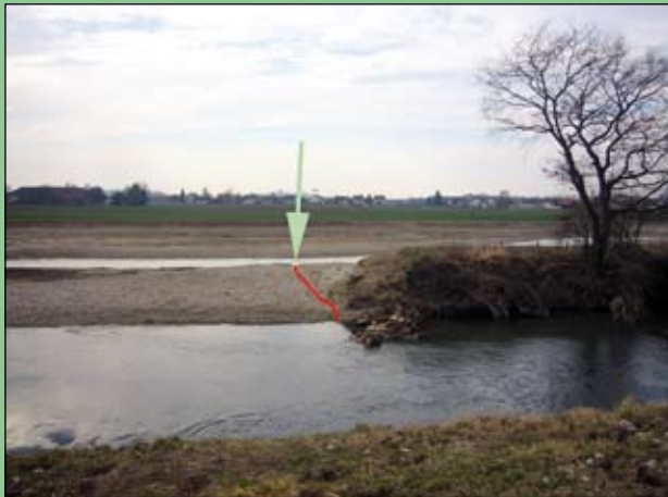
Abb. 8: Die Wurzelstockbuhne im März 2007 nach einem kleinen Hochwasser. Während des Hochwassers hat sich bereits ein kleiner Graben (rote Linie) als Verbindung zwischen dem Hauptarm (im Vordergrund) und dem Sekundärarm (im Hintergrund) gebildet.
