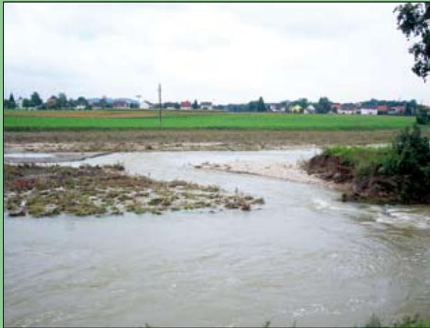
Abb. 9: Im September 2007 kam es wieder zu einem Hochwasserereignis, bei dem sich der kleine Graben schon zu einer Verbindung zwischen Haupt- und Sekundärarm entwickelte. Die Wurzelstockbuhne (im Bild rechts, überströmt; roter Pfeil) verstärkt die Strömung in den Sekundärarm noch zusätzlich. Im Uferbereich der Insel kommt es bereits zu größeren Erosionen.
