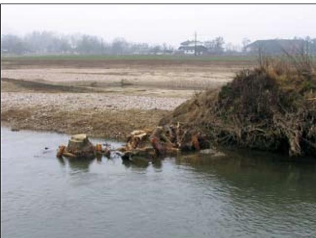
Abb. 4: Beispiel für eine fertiggestellte Wurzelstockhubne in der Kreams.
