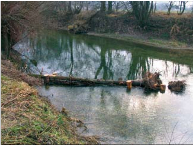
Abb. 2: Beispiel für eine fertiggestellte Stammuhne im Gewässerbett der Kreams.
