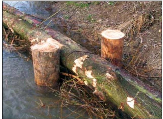
Abb. 3: Drahtseil-Befestigung der Baumstämme an den eingeschlagenen Holzpiloten.
