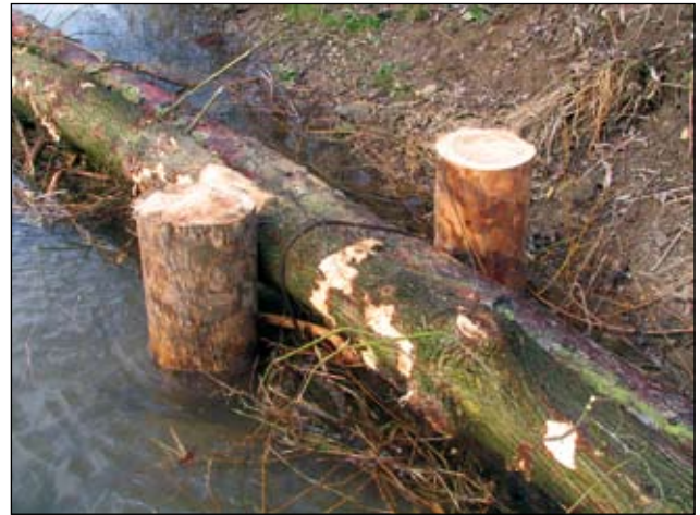
Abb. 3: Drahtseil-Befestigung der Baumstämme an den eingeschlagenen Holzpiloten.
