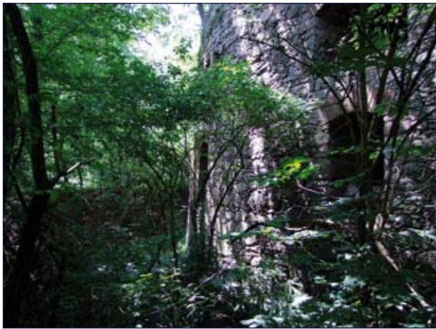
Abb. 15: Der Turm Nr. 15 der Maximilianischen Verteidigungsanlage namens „Luitgarde“ steht frei und verwildert als Ruine mitten im Wald.
