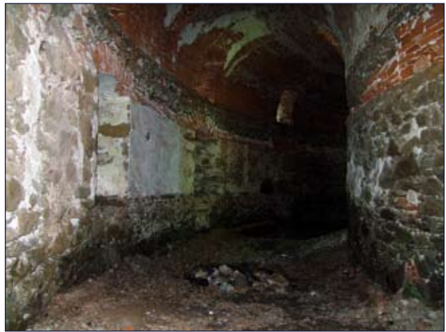
Abb. 16: Blick in das Innere des 15er-Turmes mit dem im Kreis geführten Gang aus Steinmauern und Ziegelgewölbe.
