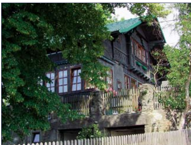
Abb. 9: Holzvilla am Schablederweg. Die meisten der alten Häuser wurden um die Jahrhundertwende von reichen Linzer Bürgern errichtet.
