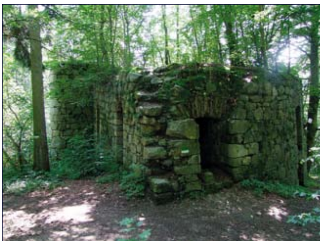
Abb. 17: Die Warte „Edelburga“ ist ebenfalls noch guterhalten. Im Gegensatz zu den rund gebauten Türmen ist die Warte halbrund geformt. Donauseitig schließt die Anschlussmauer an.
