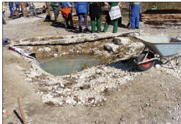
Abb. 28: Bau eines Sicker-Speicher-Teiches bei einer Praxiswerkstätte der Akademie für Umwelt und Natur im Garten des Siedlervereins auf der Landesgartenschau 2011 in Ritzlhof. Foto: M. Kumpfmüller
