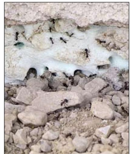
Abb. 2: Hier drängen die Waldameisen bereits in den Schaumstoff der Kellerisolierung. Fotos 1 und 2: J. Ramsebner
