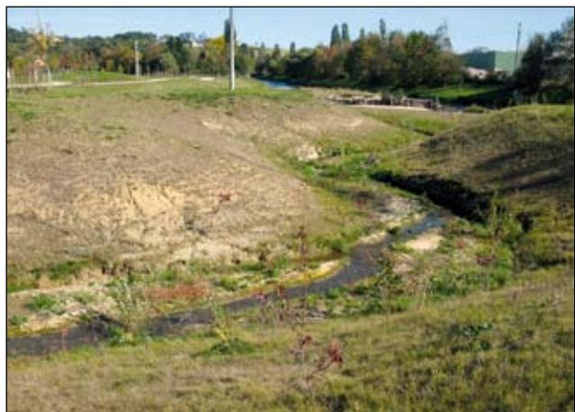
Abb. 16: Und etwa ein Jahr nach Herstellung finden sich auch schon reichlich standortgerechte Vegetationsbestände am Bachbett; die Entwicklung der Gehölze wird naturgemäß noch länger dauern. (Standort wie Abb. 14, 8. 10. 2010)
