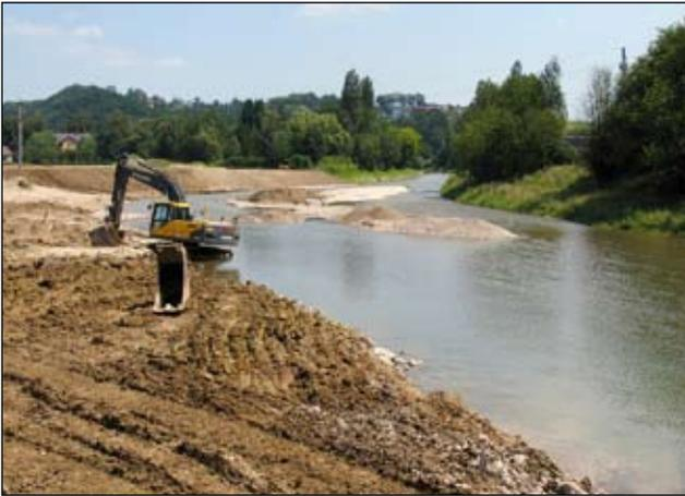
Abb. 7: Das linke Ufer wurde großzügig aufgeweitet und der Hauptlauf der Kreams an das Prallufer verschoben. (Standort unterhalb alter Gamsbachmündung, Blick flussabwärts, 17. 7. 2009)
