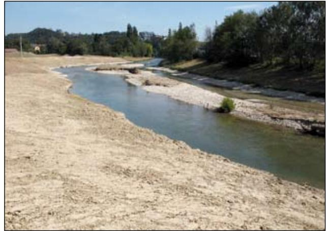
Abb. 8: Die Inseln und Schotterbänke zwischen linkem Hauptarm und rechtem Seitenarm wurden ebenfalls neu angelegt. Die Erdbauarbeiten und Einbauten sind abgeschlossen. (Standort wie Abb. 7, 9. 9. 2009)
