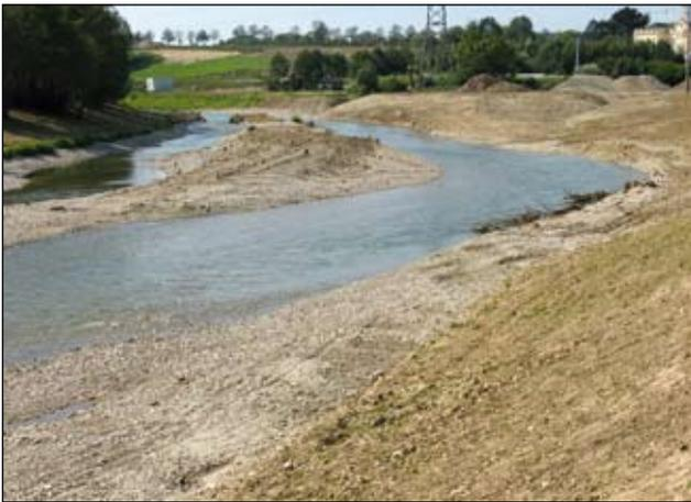
Abb. 11: Blick kremsaufwärts nahe unterem Projektsende am Ende der Erdbauarbeiten und Einbauten. Zwischen Hauptarm (rechts) und Seitenarm (links) die Inseln und Schotterbänke vor dem ersten Hochwasser. (9. 9. 2009)
