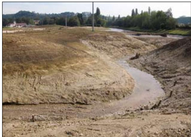
Abb. 14: Der neue Gamsbach wurde in naturnah gewundenem Verlauf angelegt. Im Bild kurz nach Herstellung mit erster Wasserführung. Im Hintergrund die neugestaltete Krems (Blick bachabwärts, 16. 9. 2009)
