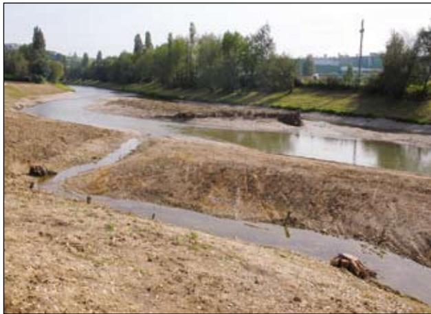
Abb. 17: Die Mündung des neuen Gamsbaches in die Krems mit erster Wasserführung kurz nach Ende der Erdbauarbeiten. (16. 9. 2009)
