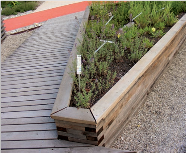
Abb. 2: Holzdeck und Pflanzbehälter aus gehobelten Eichenbohlen mit silbergrau verwitterter Oberfläche. Foto: E. Kals
