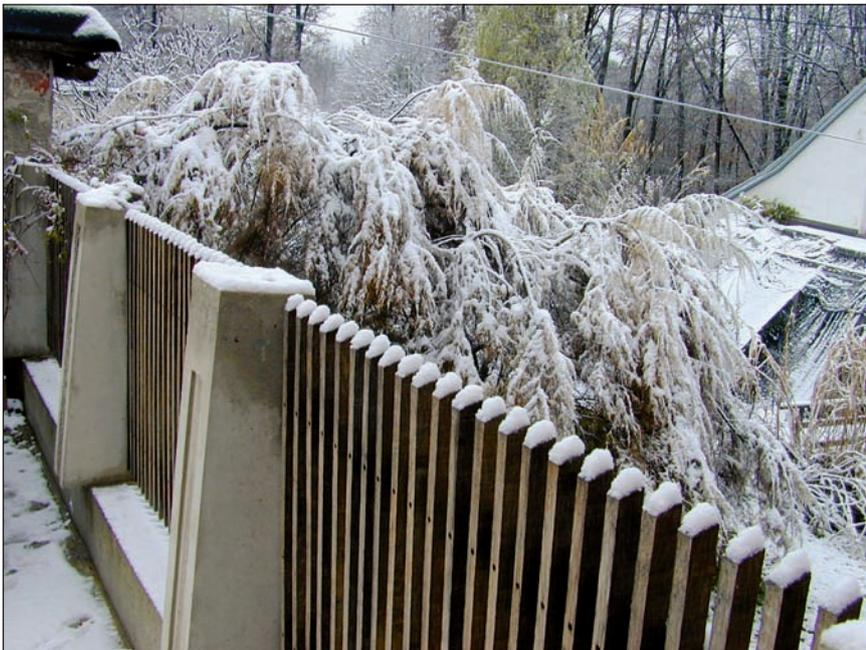
Abb. 9: Abgeschrägte Köpfe sorgen für rasches Auftrocknen der Hirnholzflächen und beugen Pilzbefall vor.
