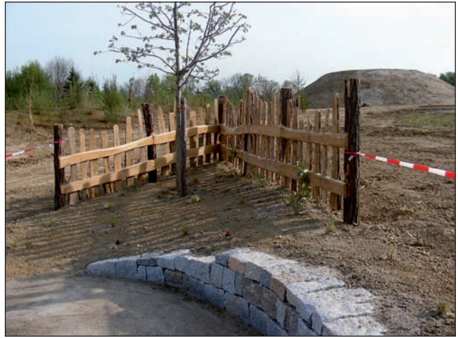
Abb. 3: Dauerhafter Zaun aus Robinie mit hohem Lebensraum-potenzial: Steher aus Rundstämmen mit Borke, Träger aus Zweischneidern, senkrechte Lattung aus Schwarten mit Borke. Foto: M. Kumpfmüller
