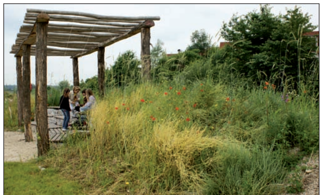
Abb. 5: Funktionsgerechte Materialverwendung: Bänke aus gehobeltem Robinienholz, Säulen aus Robinien-Rundstämmen mit Borke, Träger aus Lärchen-Halbstämmen, Reiter aus beliebigem Durchforstungsholz. Foto: E. Kals
