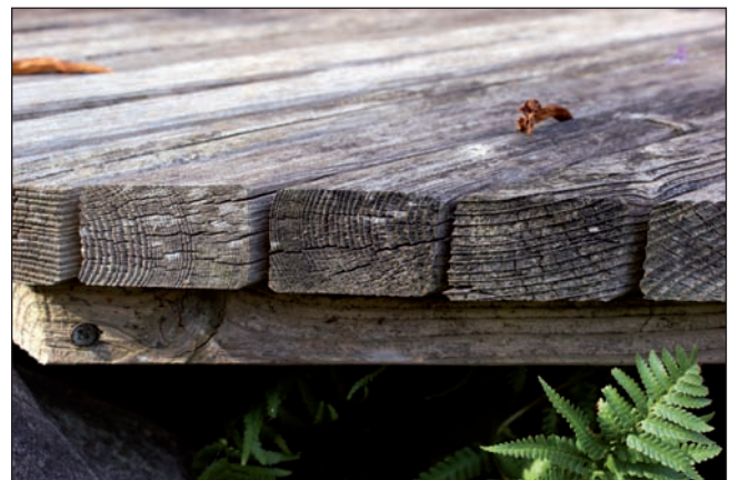
Abb. 8: Die beiden linken Kanthölzer sind auf Rift geschnitten - stehende Jahrringe. Rechts Fladerschnitt. Foto: M. Kumpfmüller
