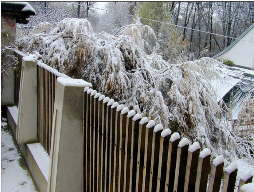
Abb. 9: Abgeschrägte Köpfe sorgen für rasches Auftrocknen der Hirnholzflächen und beugen Pilzbefall vor. Foto: M. Kumpfmüller
