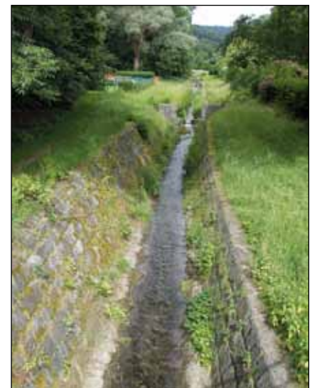
Abb. 1: Der Höllmühlbach wirkt im unteren Abschnitt eher kanalartig: einheitliches Trapezprofil Sohle, Ufer und abgesetzte Sohltrappen gepflastert. Zur Zeit der Errichtung standen der Schutz vor Grundwasserverunreinigung und der technische Hochwasserschutz im Mittelpunkt. Auf ökologische Zusammenhänge wurde damals noch weniger geachtet.
