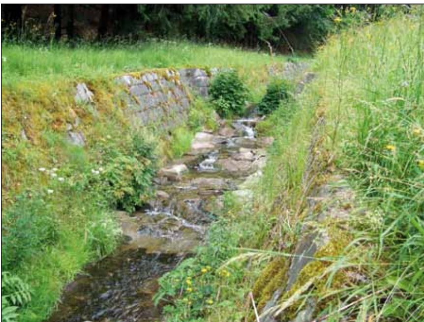
Abb. 5: Mittels aufgelöster Sohlterappe aus Wasserbausteinen wurden die unpassierbaren Sohlabstürze abgemindert, was sich für Bachtiere, die sich gegen die Strömung orientieren und bachaufwärts wandern, positiv auswirkt.
