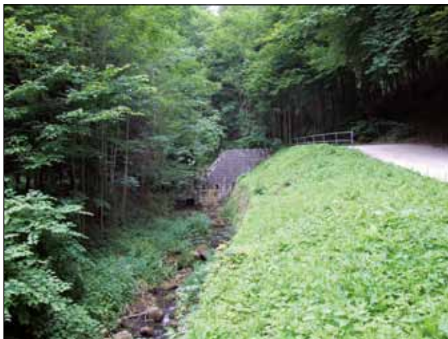
Abb. 11: Diese Geschiebesperre soll bei Hochwasser abgeschwemmtes Material auffangen, damit es im verbauten Gebiet keine Schäden anrichten kann.
