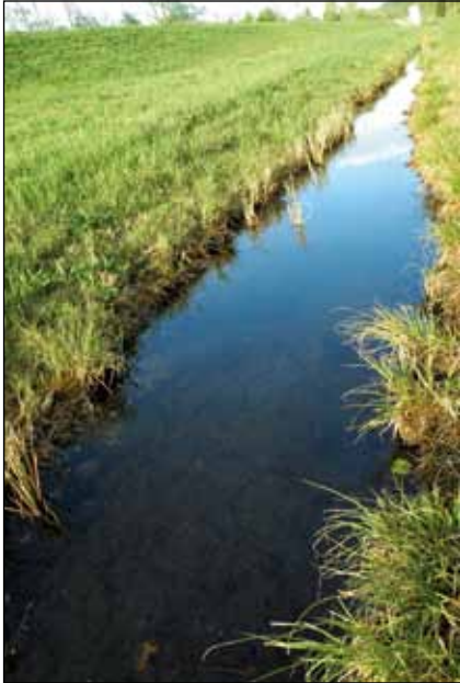
Abb. 32: Der Sickergraben am Fuß des Hochwasserschutzdammes beim Pumpwerk im Mühlthal in Überackern – die Zerbrechliche Armleuchteralge ( Chara globularis ) trotz auch einer leichten Verockerung des Gerinnes.
