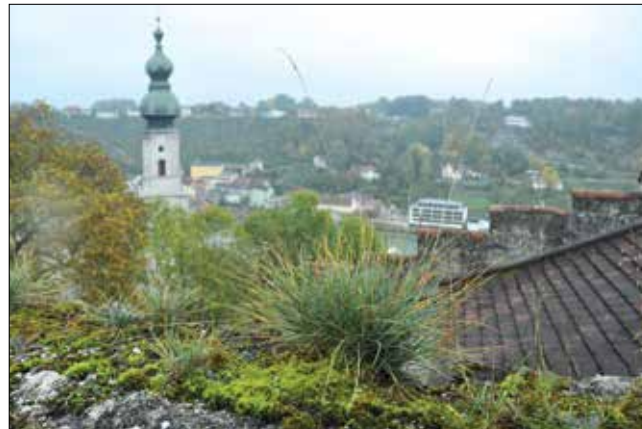
Abb. 7: Der Bleich-Schwingel ( Festuca pallens ) auf und an den Mauern der Burganlage in Burghausen
