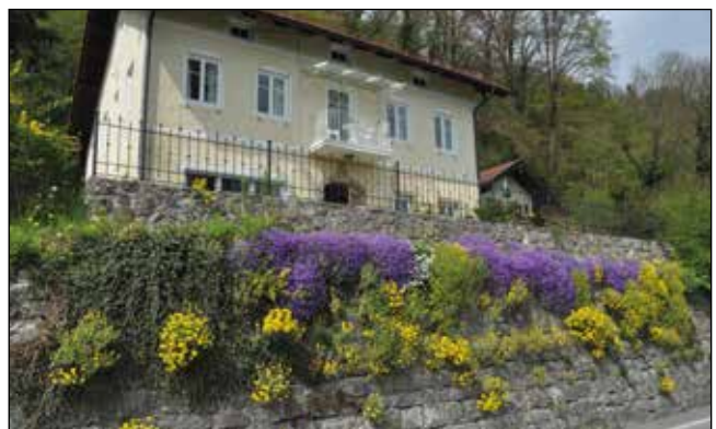
Abb. 60: Prachtvolle Stützmauer mit Felsensteinkraut ( Aurinia saxatilis ) und Blaukissen ( Aubrieta x cultorum ) – an der Straße zwischen Burghausen und Raitenhaslach in Bayern
