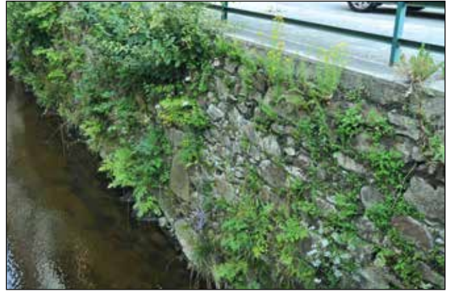
Abb. 13: Eine prachtvoll bewachsene Ufermauer an der Steinernen Mühl in Helfenberg
