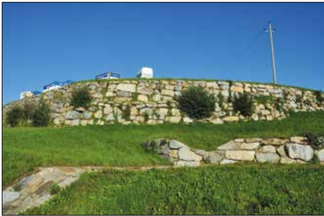
Abb. 10: Wie Bastionen wirken große Stützmauern in hügeligen Gebieten zum Gewinnen ebener Flächen
