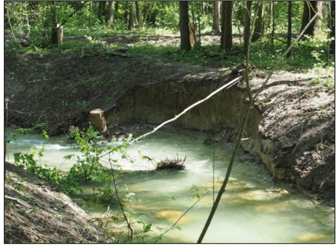
Abb. 12: Das Umgehungsgerinne fürs Annawehr ist mehr als ein „Fischaufstieg“: Kaum angelegt, arbeitet der Bachlauf schon selber an seiner noch natürlicheren Ausgestaltung. Man erkennt einen frischen Unferanriss im Ausand.
