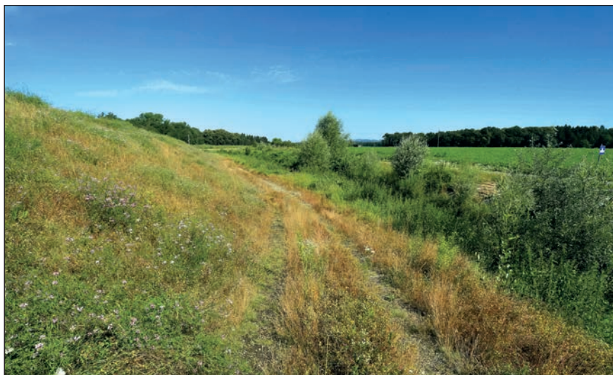
Abb. 10: Magerstandorte des Hochwasserschutzdammes sowie Gehölzbestände entlang einer Umlegungsstrecke bei Mettendorf konnten als Brutrevier des Neuntöters ( Lanius collurio ) 2016 und 2018 sowie auch des Bluthänflings ( Linaria cannabina ) 2016 dokumentiert werden. Foto: Marcus Weber
