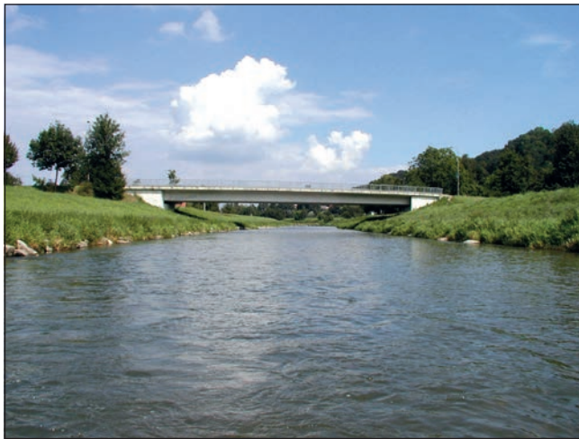
Abb. 7: Auch die oberösterreichische Krems wurde über weite Strecken begradigt und gleicht einer „Wasserautobahn“.
