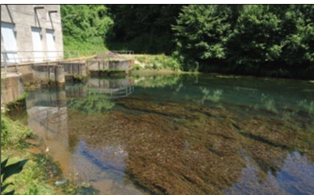
Abb. 33: In den Pumpteichen werden die Quell- und Sickerwässer gesammelt, um dann über den Damm in den Fluss gepumpt zu werden – hier das Pumpwerk Ranshofen/Braunau mit dichten Beständen des Krausen Laichkrauts ( Potamogeton crispus ).
