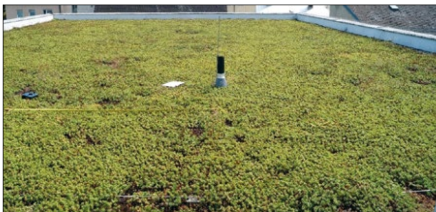
Abb. 12: Freifläche einer Dachfläche im Zentrum von Linz
