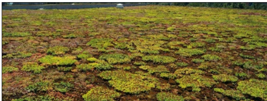
Abb. 9: Dicht bewachsenes Gründach. Bei den braunen Stellen zwischen den grünen Pflanzenpolstern handelt es sich um Moose. Foto: Gregor Auinger
