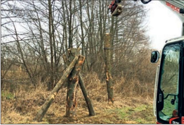
Abb. 3: Mit Hilfe eines Baggers wurden die Stämme um den zentralen Stamm platziert. Foto: ÖNB Stmk
