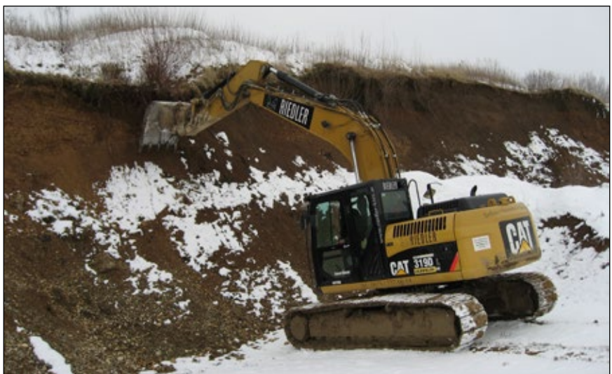
Abb. 13: Mit schwerem Kettenbagger wird eine erodierte Steilwand am Rande einer Schottergrube wieder frisch abgestochen, um sie als Brutplatz für Uferschwalben, Bienenfresser und Insekten zu attraktivieren. Foto: Werner Weißmair
