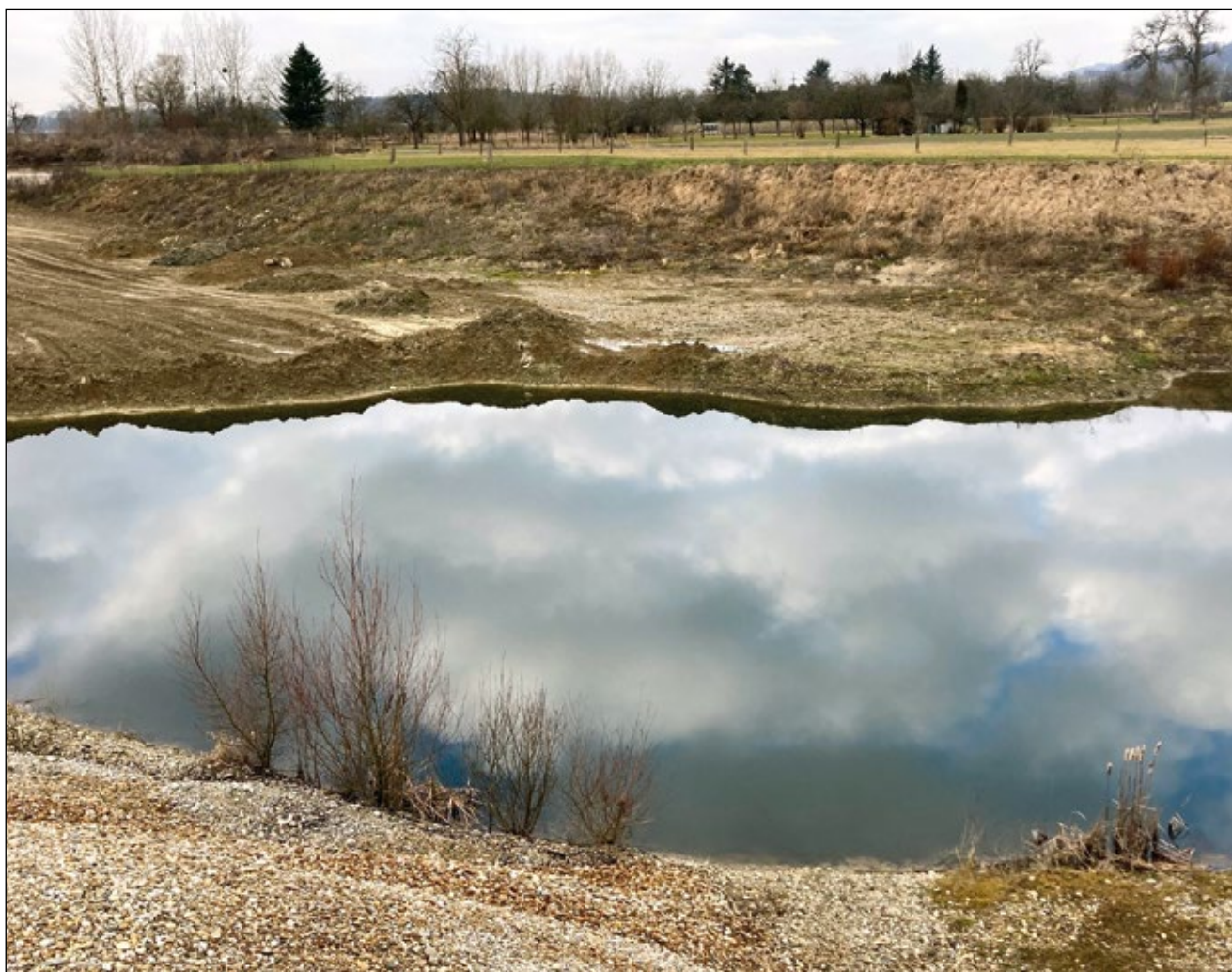
Abb. 1: Fertig abgebaute Schottergrube im Bezirk Perg und beginnende Verfüllung mit Erdaushub
