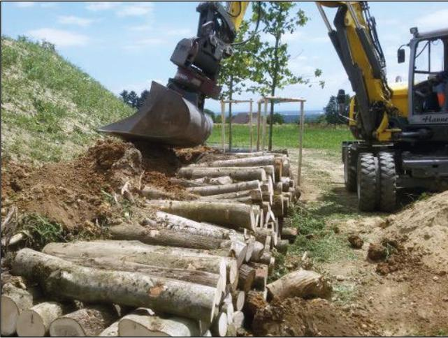
Abb. 3: Vor einer Böschung wird mit einem Teil des Aushubs aufgefüllt, ansonsten nach unten angeklippt.
