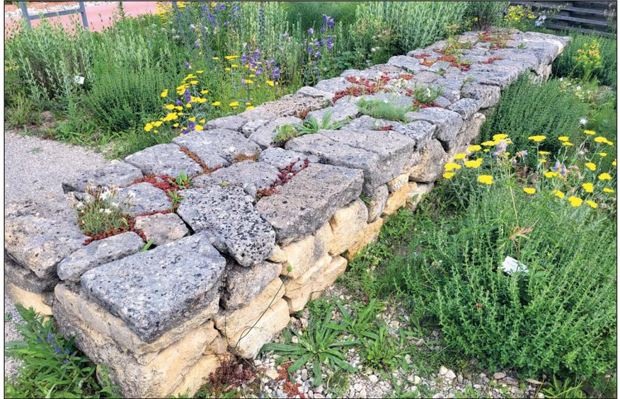
Abb. 11: Trockenmauern bestehen aus geschichteten Steinen ohne Vermörtelung. Sie sind allein durch das Gewicht der Steine und die fachgerechte Schichtung stabil. In den Fugen können sich kleine Tiere wie Käfer, Amphibien und Reptilien gut verkriechen und auch Trockenpflanzen wachsen.
