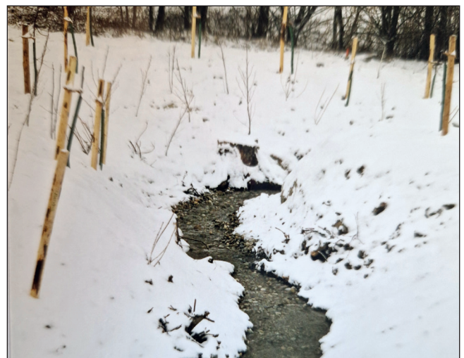
Abb. 4 u. 5: Rückbau einer 60 m langen Verrohrung eines Zubringers zur Faulen Aschach
